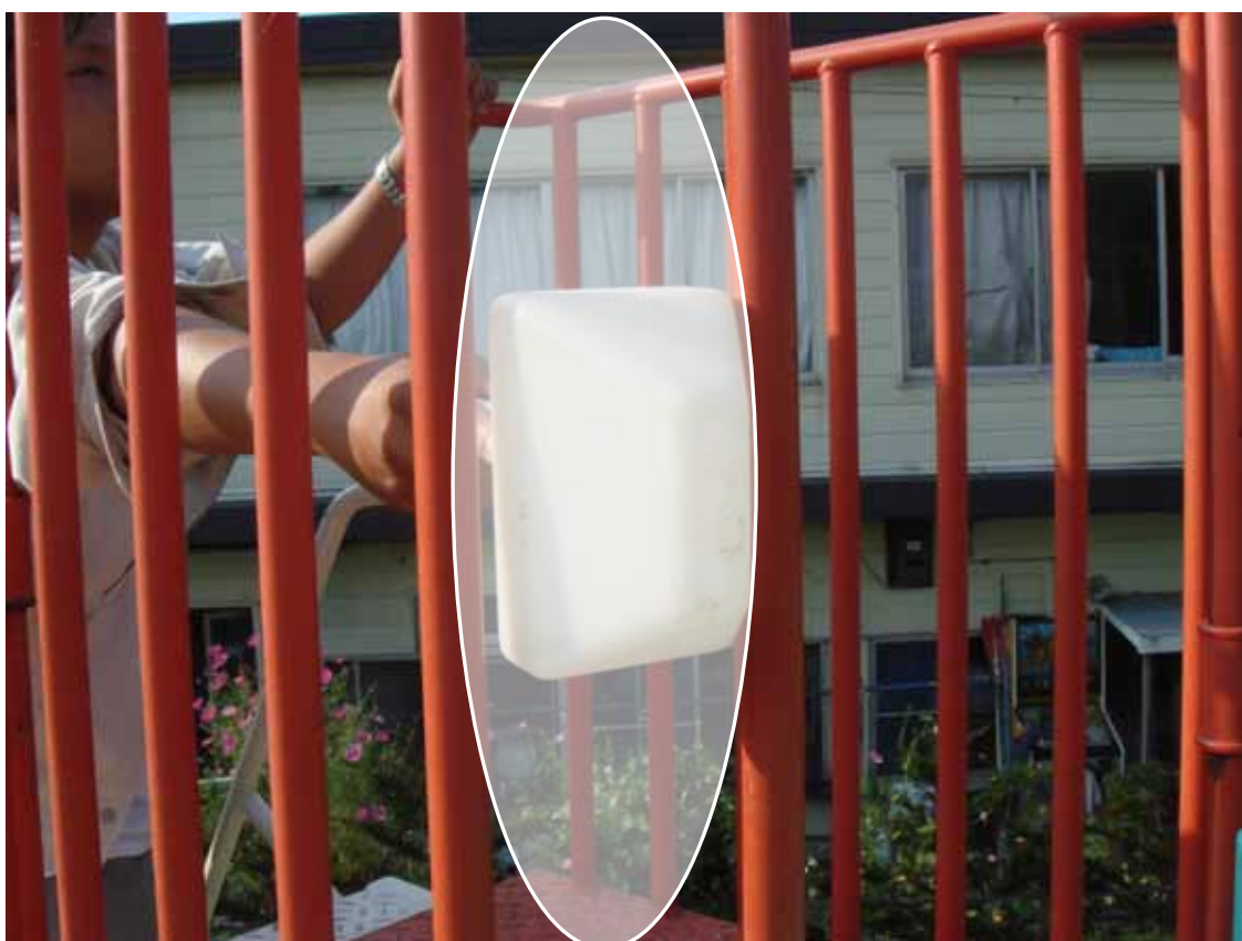
写真2 危険な隙間を無くす。(検査器具が通過しないようにする。100mm以下)
